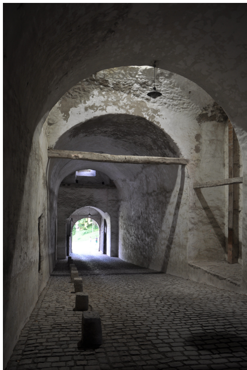
Torbau mit Zugang - Tonnengewölbe
